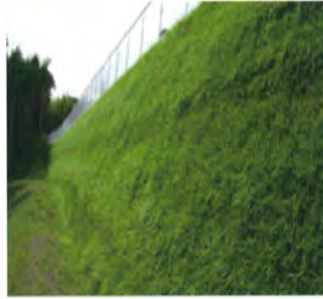
補強盛土壁 施工3ヶ月後
