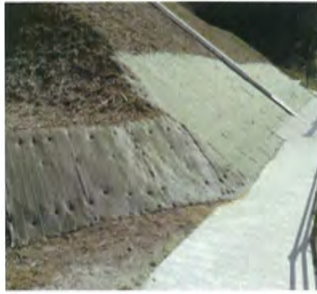
スポーツ公園のり面 施工直後
