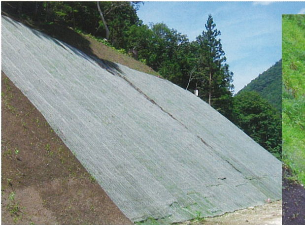
MF-45R-10wn 施工直後
