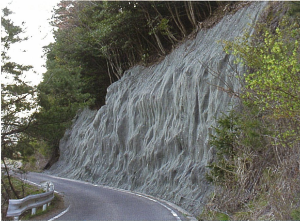
SP-45wn 施工直後
